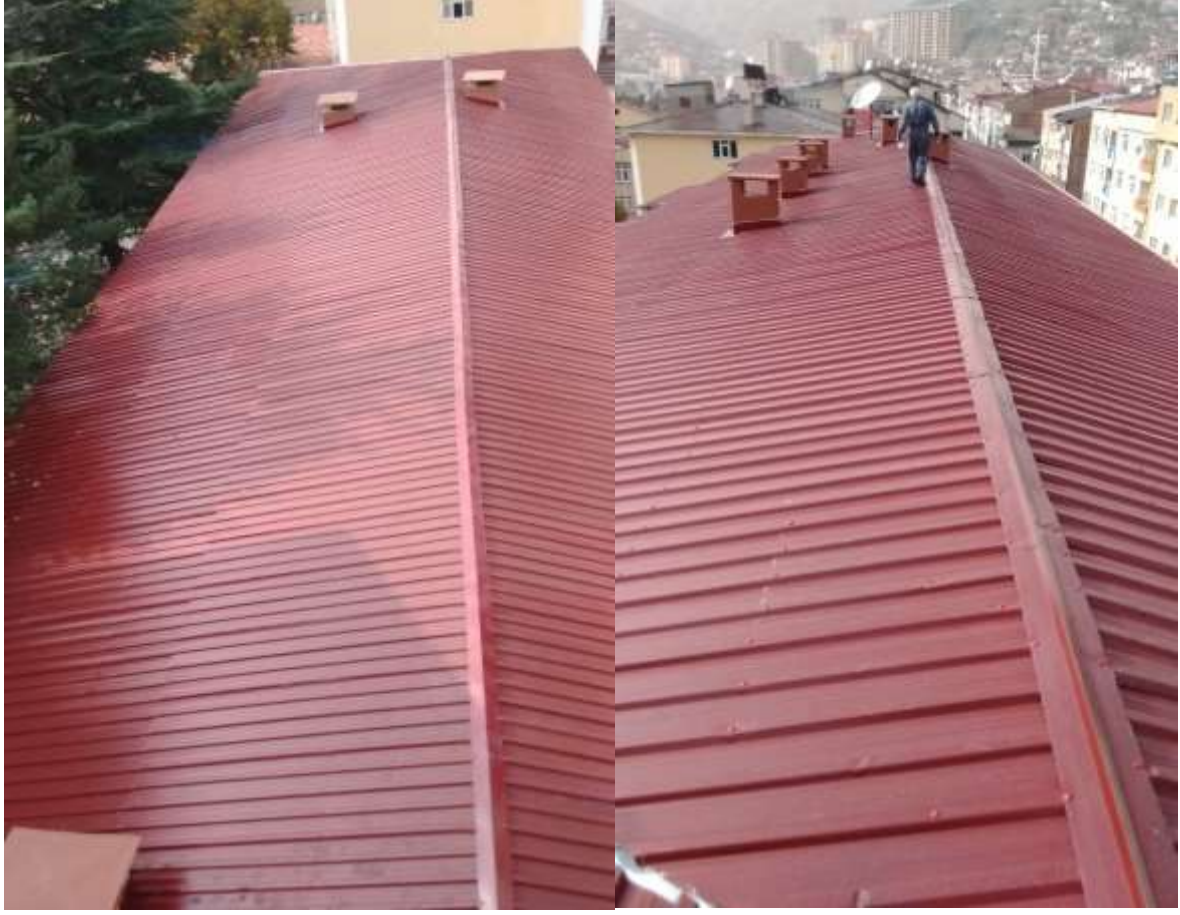
Gümüşhane İl Meclis Binası Doğalgaz Dönüşümü ve Çatı Onarımı İşİ (2. Kısım Çatı Onarımı)
