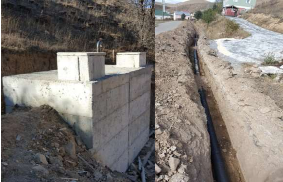
Merkez Güvercinlik Köyü Kanalizasyon Hattı ve 100 Kişilik Fosseptik Yapım İşİ
