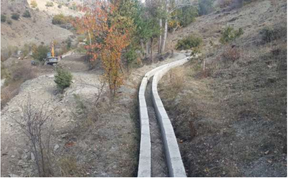
Merkez Keçikaya İçmesuyu Tesisi
