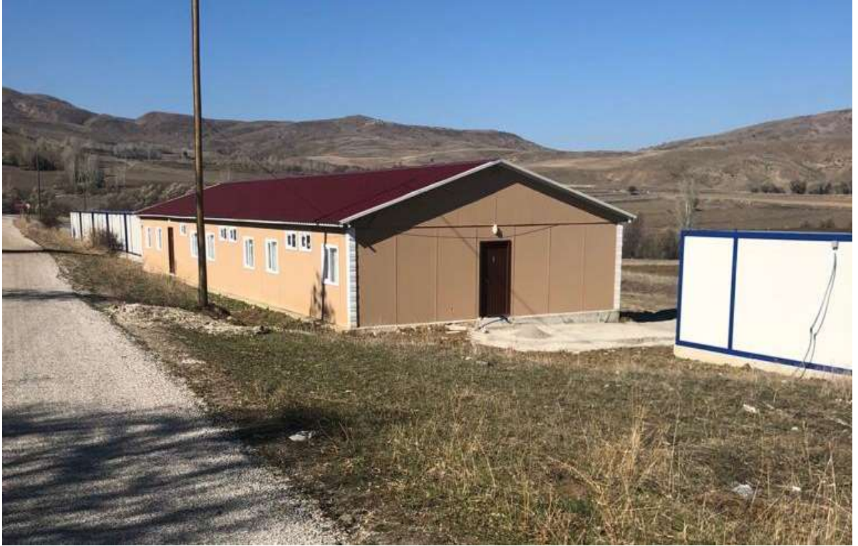
Kelkit İlçesi Sadak Köyü Prefabrik Şantiye Binası Yapım İşi
