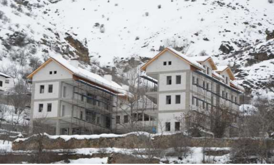
Süleymaniye Kültür Kompleksi Binası Betonarme İmalatları Yapım İşi
