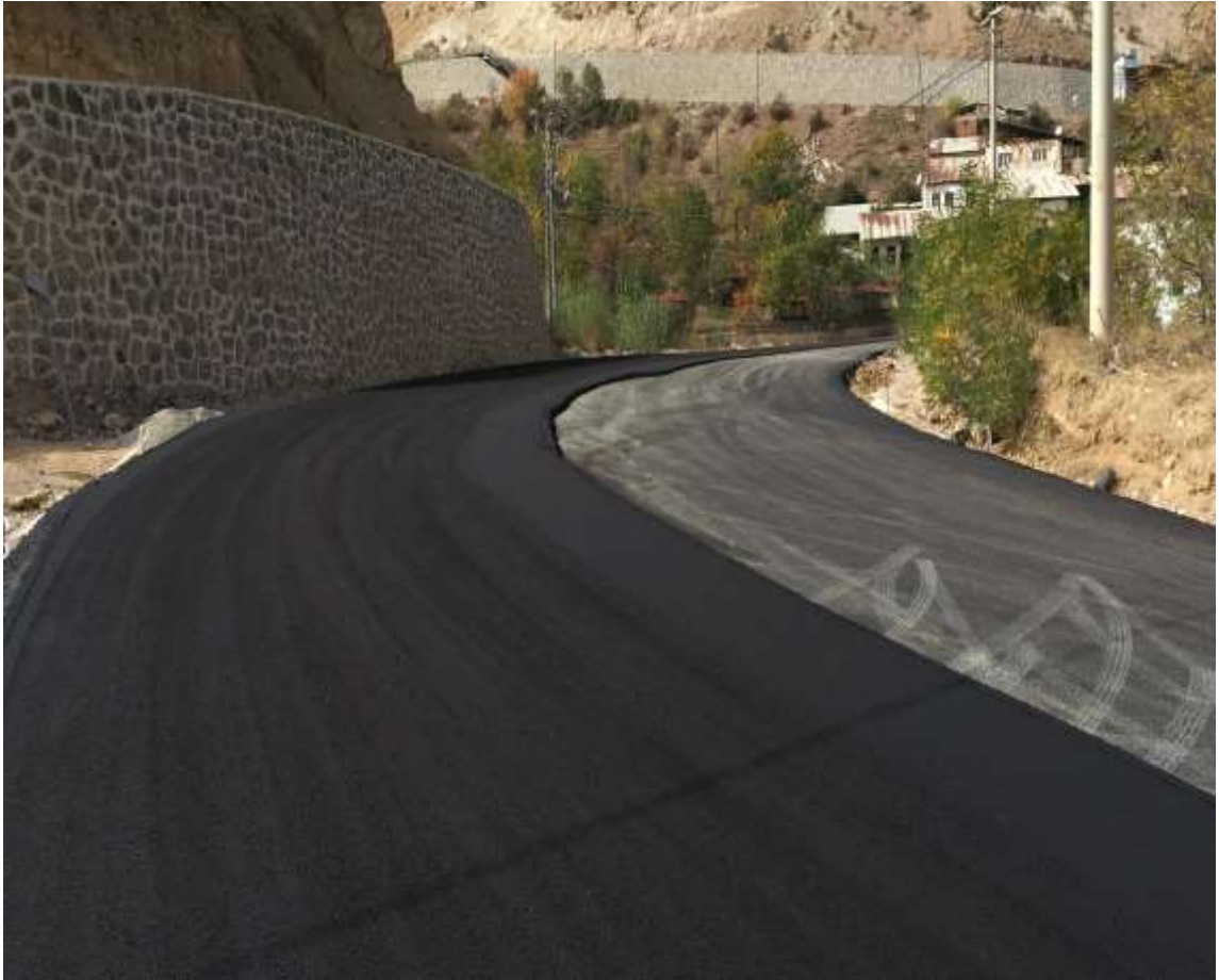
Merkez Alemdar Köyü Asfalt ve Taş Duvar İşi
