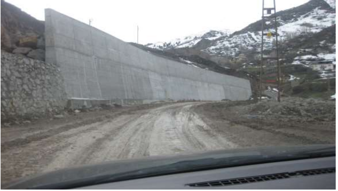
Merkez Süleymaniye Mahallesi Yol Çalışması
