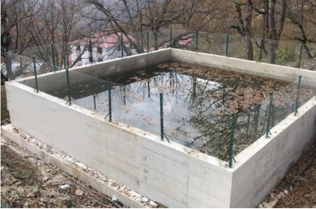
Merkez Yeniöl Köyü Gölet Çit Yapım İşi
