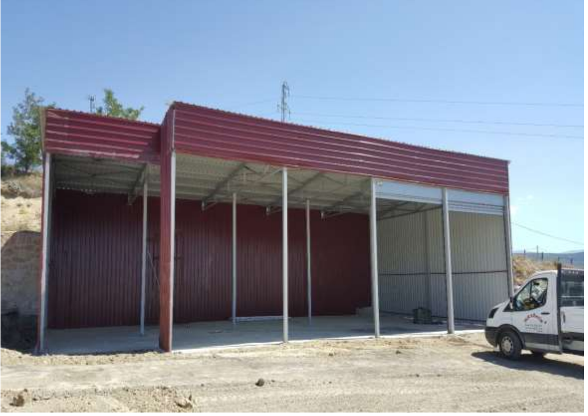
Şiran İlçe Özel İdare Müdürlüğü Sundurma Yapım İşi
